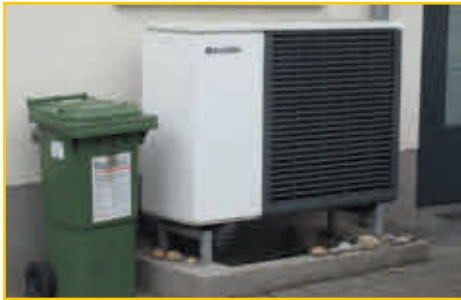
Wärmepumpe (BVO)
